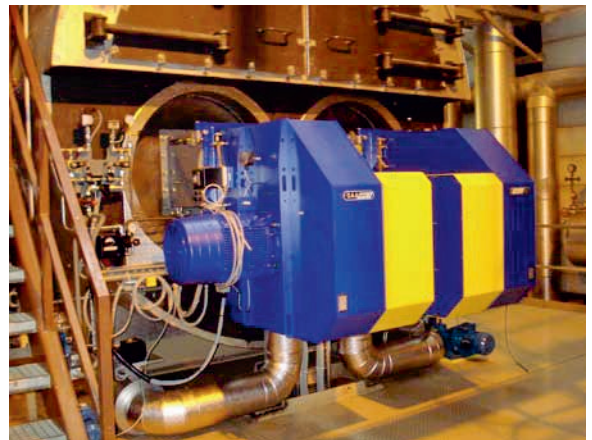
Nach dem Umbau
